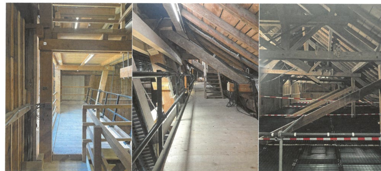
Premier niveau de passerelle, côté jardin
