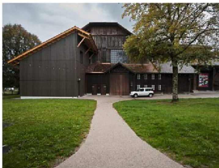
Contre le bâtiment historique, une extension a remplacé celle datant des années 60. Elle accueille technique et administratif.
