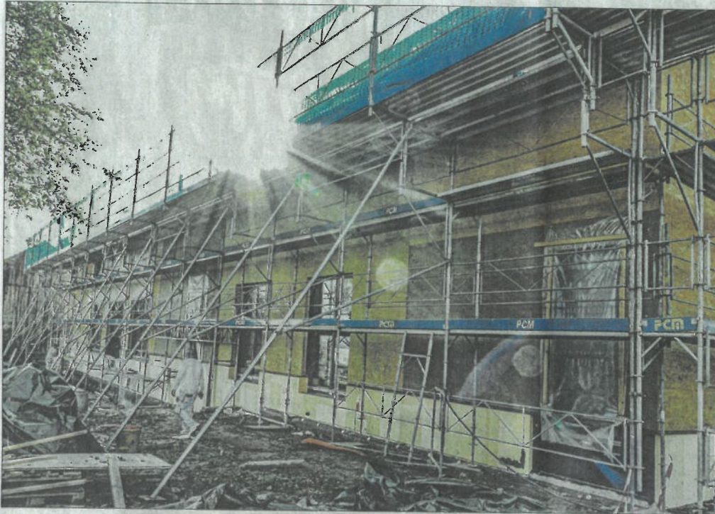
Le pavillon prend forme avec son isolation
