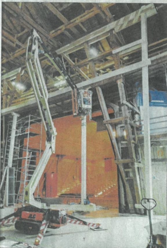
Renforcement des infrastructures de la scène en bois massif
