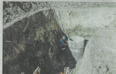
Des fondations très profondes se sont avérées indispensables
